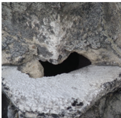
Fot. 62. Wykonana z gipsu sztukateria w kamienicach często ulega uszkodzeniu odsłaniając puste wnętrza... (DZ).
