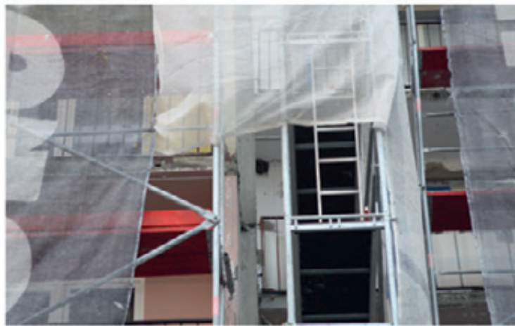
Fot. 1. Gniazdo oknówki uwięzione między rusztowaniami. Budynek ul. Pultusk.
