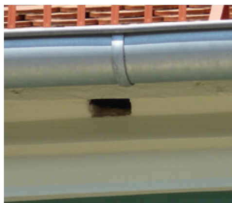
Fot. 102. W tej szczelinie pod krawędzią dachu Urzędu Miasta w Szczecinie gniazdowała para jerzyków. Po remoncie elewacji pozostawiono im swobodny dostęp do gniazda poprzez otwór o wysokości 3, 5 cm i szerokości 6 cm (DZ).
