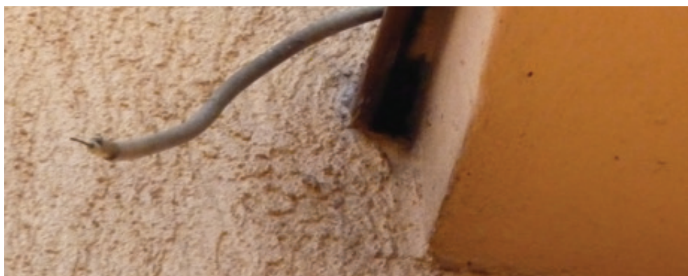
Fot. 81. Ciemna plama na styku balkonu i elewacji to szczelina nie większa niż 2cm, która jedynie z niedokładności robotników wykonujących termomodernizację nie została zasłonięta, pozwalając nietoperzom nadal korzystać z tego miejsca (DZ).
