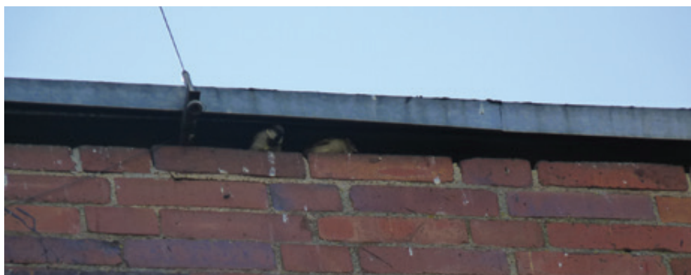
Fot. 51. Pod obróbką blacharską dachu płaskiego, pomimo pozornie wysokich temperatur tam panujących miejsce na gniazdo wybrały wróble. Podobne miejsca mogą być zajmowane przez kolonie rozrodcze nietoperzy (DZ).
