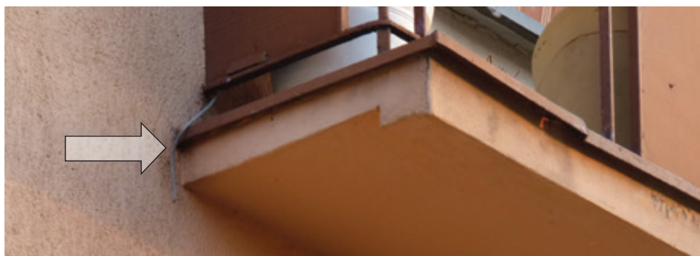
Fot. 80. W tym budynku na styku podłogi jednego z balkonów i ściany, pod obróbką blacharską znajduje się niemal niezauważalne wejście do kolonii rozrodczej karlików malutkich (DZ).
