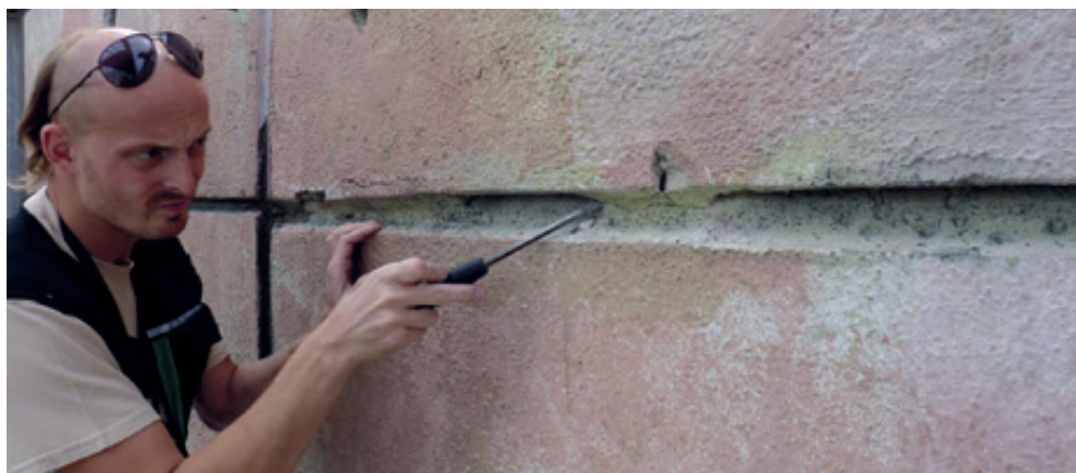
Fot. 79. Odchody nietoperzy są bardzo lekkie, bardzo szybko wysychają i są zwiewane przez wiatr, dlatego aby upewnić się czy ich nie ma należy usunąć nieco spoiwa, aby odsłonić odchody które mogły się tam zgromadzić (DZ).
