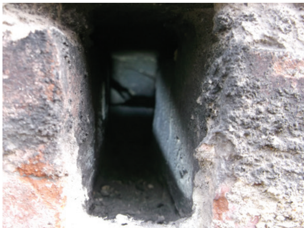
Fot. 97. Ta szczelina prowadzi daleko w głąb elewacji, poza zasięg metrowej długości kamery endoskopu. Może to być potencjalne zimowisko nietoperzy (DZ).
