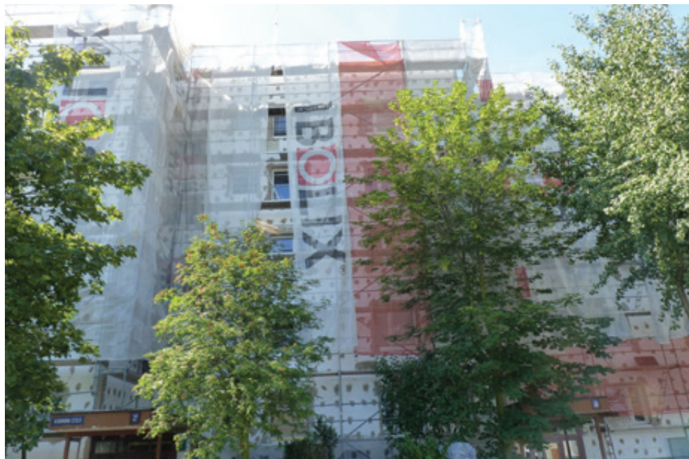
Fot. 20. Budynek wielkopłytowy w trakcie docieplenia (DZ).
