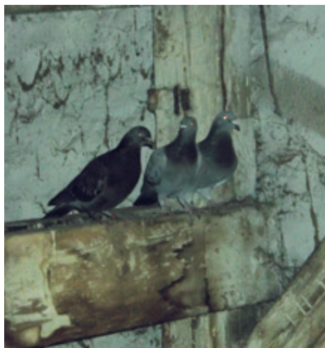
Fot. 70. Gołębie miejskie zasiedlające strychy (DZ).
