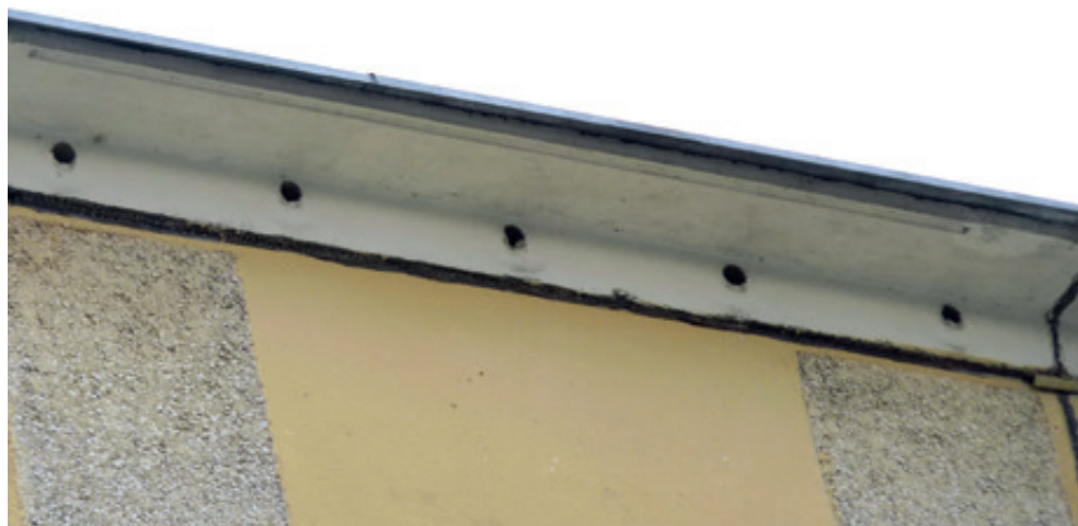
Fot. 29. Otwory wentylacyjne stropodachu, w którym stwierdzono gniazdowanie jerzyków (DZ).
