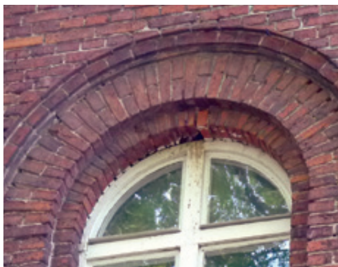
Fot. 46. Niewielki ubytek u szczytu okna zapewnia wystarczającą przestrzeń dla jerzyków do odbicia łęgów. Odchody poniżej prawdopodobnie zostały pozostawione przez przebywające tam wcześniej wróble (DZ).
