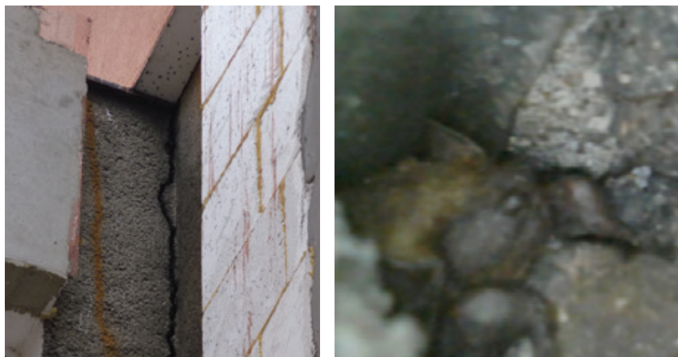
Fot. 96. Prace termomodernizacyjne tego budynku musiały zostać wstrzymane na 6 miesięcy okresu zimowego, ze względu na borowce wielkie gromadzące się na zimowisko w szczelinie dylatacyjnej (DZ).
