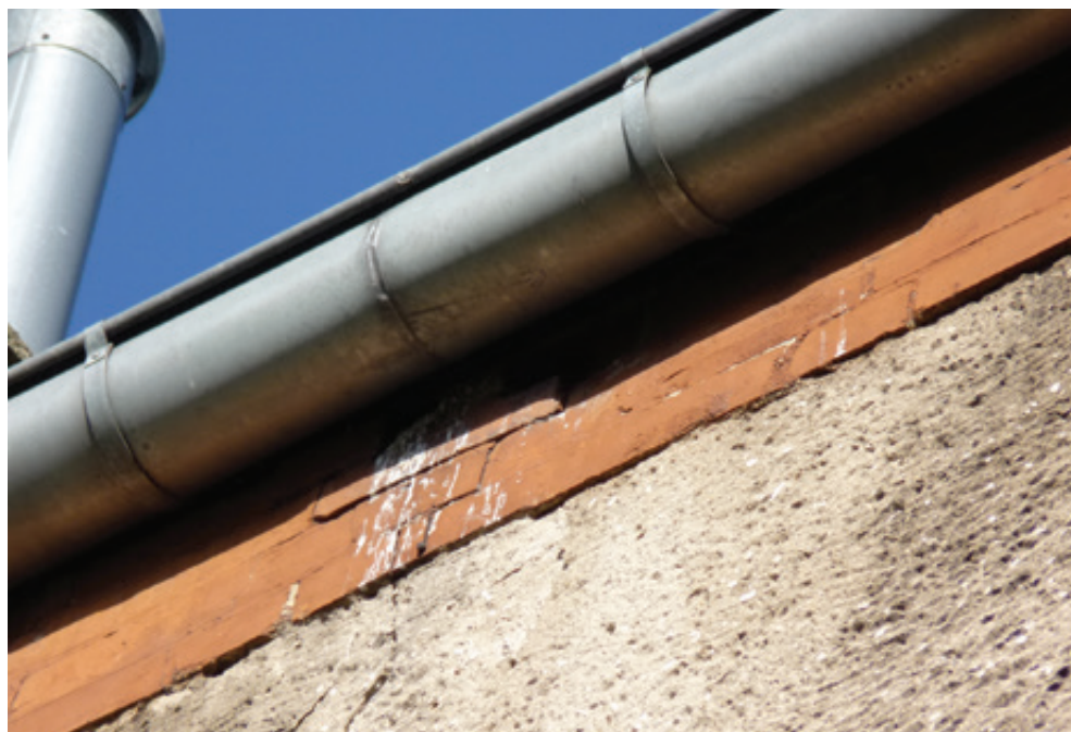
Fot. 60. Pobielenie kałem na elewacji, W tym miejscu regularnie przesiadywały wróble, ale nie odbywały lęgów (DZ).
