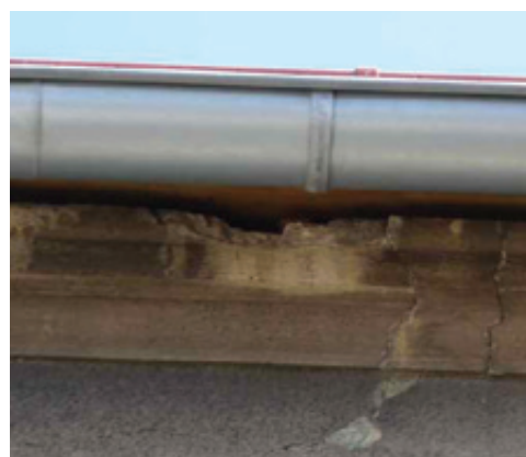
Fot. 102. W tej szczelinie pod krawędzią dachu Urzędu Miasta w Szczecinie gniazdowała para jerzyków. Po remoncie elewacji pozostawiono im swobodny dostęp do gniazda poprzez otwór o wysokości 3, 5 cm i szerokości 6 cm (DZ).
