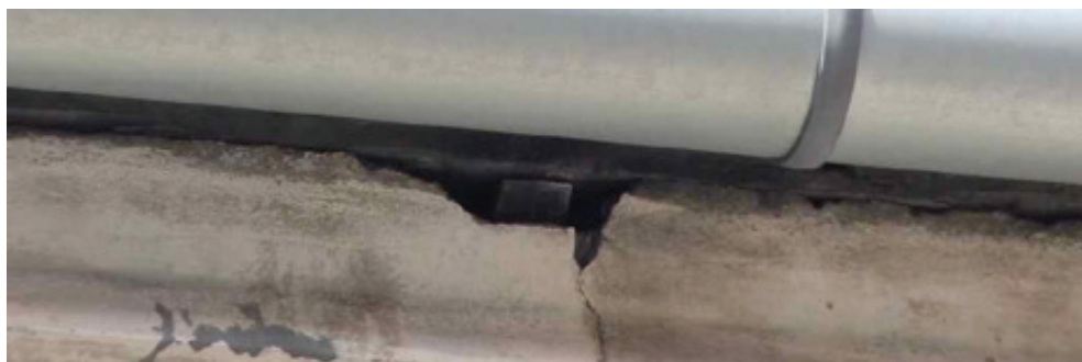
Fot. 49. Ta niewielka szczelina prowadziła do gniazda jerzyków. Pomimo jasnego odcienia elewacji ślady pod szczeliną nie powstały (DZ).
