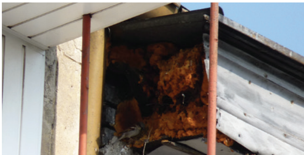
Fot. 50. Uszkodzona boczna część gzymsu umożliwiła gniazdowanie w jego wnętrzu wróblom oraz jerzykom (DZ).
