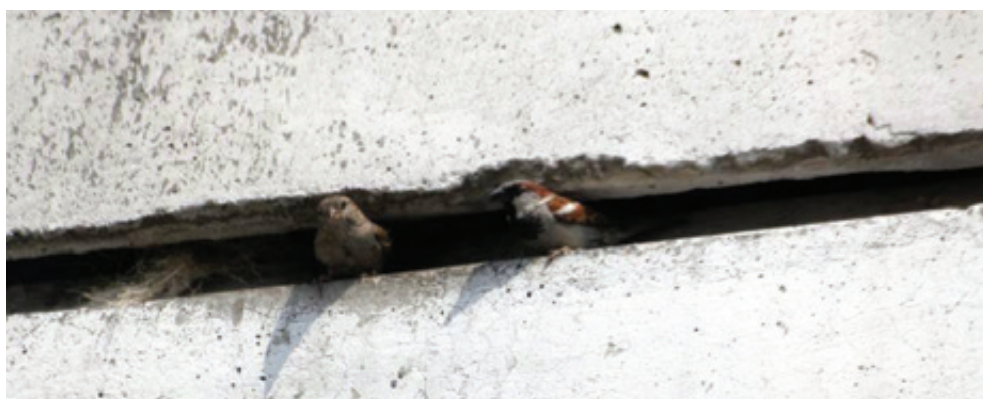
Fot. 37. Wróble gniazdujące w szczelinie dylatacyjnej (AT).
