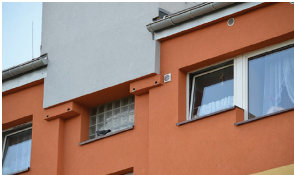
Fot. 106. Skrzyńki drewniane zamontowane w warstwie ociepliny i otynkowane (AT).
