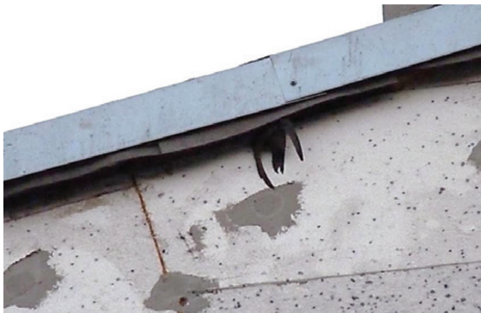
Fot. 21. Ten jerzyk próbuje bezskutecznie dostać się do gniazda które zajmował rok wcześniej. W wyniku sporządzenia opinii jesienią prace termomodernizacyjne budynku zostały przeprowadzone bez uwzględnienia ochrony miejsc gniazdowania ptaków, bądź kompensacji za ich zniszczenie (DZ).
