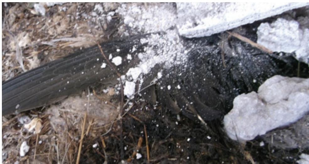
Fot. 133. Ten jerzyk został znaleziony w gnieździe na skraju dachu martwy, przysypany zdemontowanymi dachówkami. Nie można jednoznacznie stwierdzić czy zginął z winy wykonawcy prac, czy z powodu choroby (DZ).
