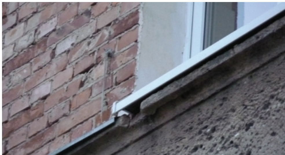
Fot. 43. Szczelina pod parapetem prowadząca do gniazda jerzyków. Ze względu na strukturę elewacji i czysty tryb życia tych ptaków, pod spodem nie ma żadnych śladów (DZ).
