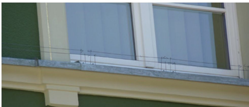
Fot. 130. Elewacje urzędu miejskiego w Szczecinie zabezpieczono przed gołębiami miejskimi za pomocą niemal niewidocznych, ale skutecznych prętów obrotowych (DZ).
