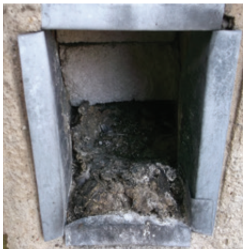
Fot. 71. Gniazdo gołębi miejskich w otworze wentylacyjnym w ścianie kamienicy. Składa się głównie z patyków i kału (DZ).
