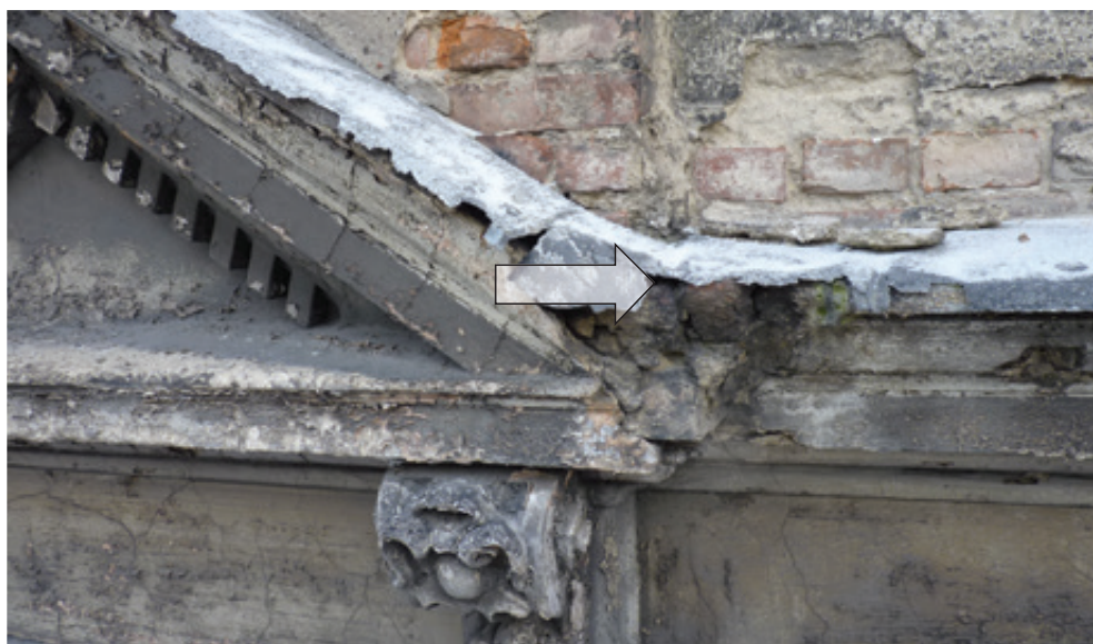
Fot. 67. Zwracać uwagę należy też na obróbki blacharskie... (DZ).
