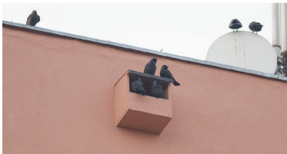
Fot. 136. Budka lęgowa dla pustulek zawieszona po remoncie (DC).
