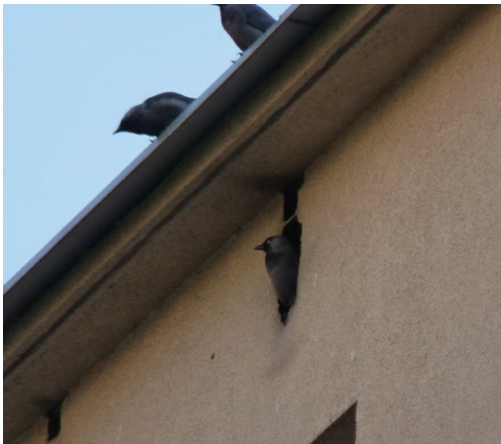
Fot. 72. Kawki gniazdujące w stropodachu (DZ).
