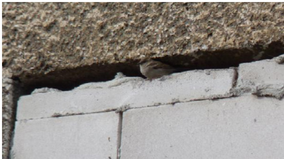
Fot. 2. Samica wróbla przy gnieździe ukrytym w zamurowanym otworze okiennym.
