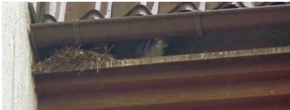
Fot. 92. Gołębie miejskie gniazdujące na gzymsie pod rynną (DZ).
