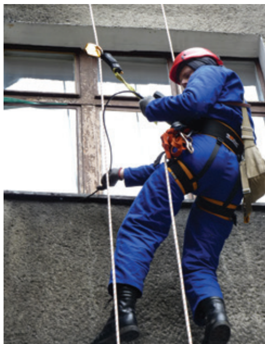
Fot. 26. W tym wypadku inspekcja parapetu byłaby niemożliwa bez wybijania szyb. Zastosowanie technik alpinistycznych pozwoliło ustalić czy jest on siedliskiem ptaków lub nietoperzy (DZ).
