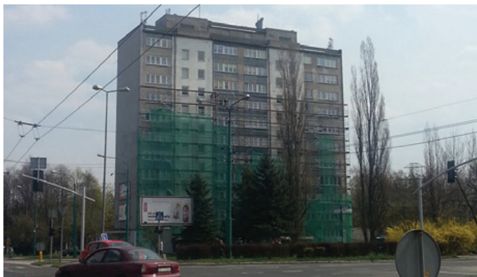
Fot. 135. Remontowany blok (DC).
