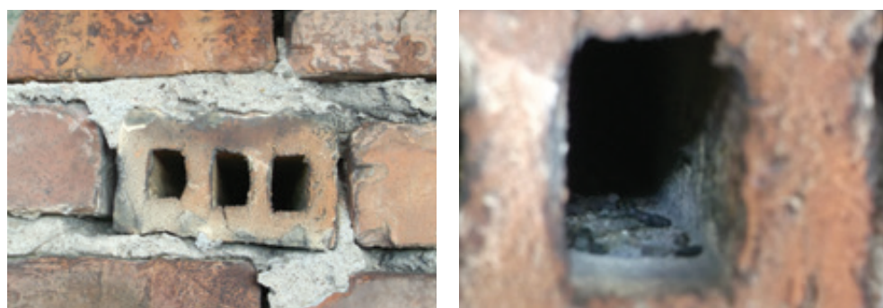
Fot. 83. Cegła dziurawka wmurowana w ścianę kamienicy na wysokości trzeciego piętra stanowiła w sezonie rozrodczym schronienie dzienne dla pojedynczego samca karlika malutkiego (DZ).
