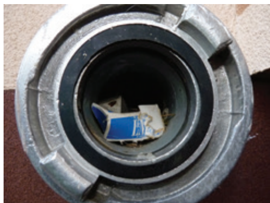
Fot. 55. Nawet zapchany odpadkami hydrant znajdujący się przy zsywie na śmieci w bloku wielkopłytowym został wykorzystany przez ptaki (DZ).
