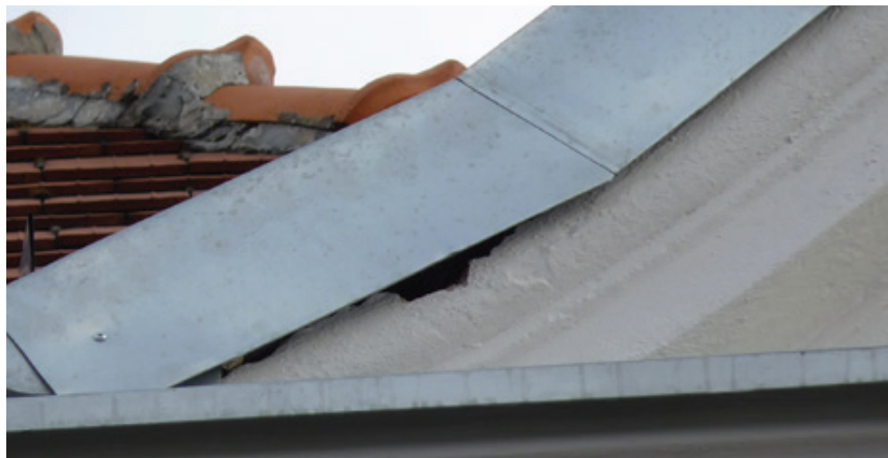
Fot. 101. Jedna z czterech szczelin pod obróbką blacharską krawędzi dachu gdzie gniazdowały jerzyki. W trakcie renowacji budynku miejsca te pozostawiono nietknięte, dzięki czemu ptaki w kolejnym sezonie mogły bez problemu powrócić do swoich gniazd (DZ).
