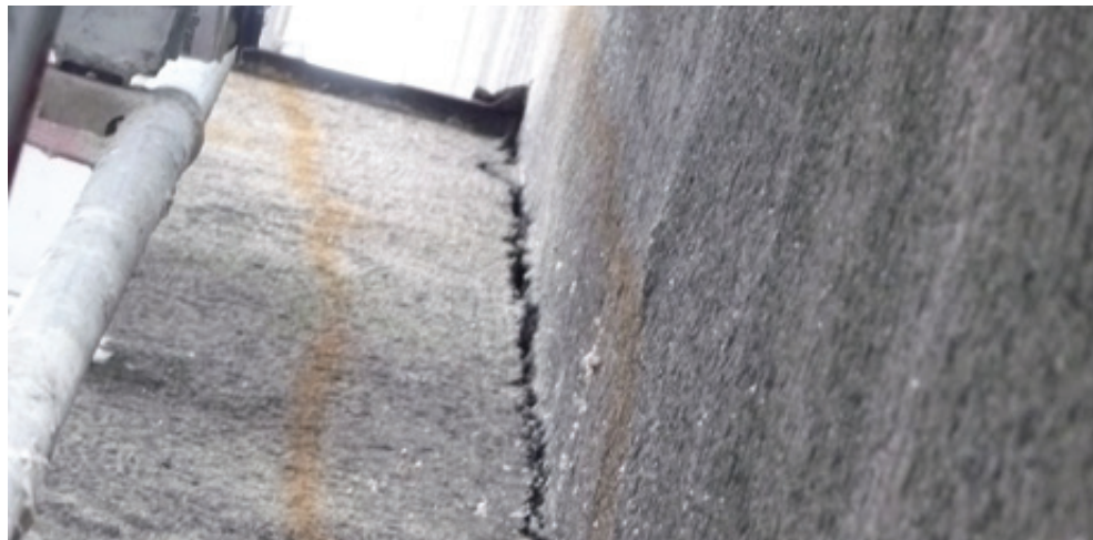
Fot. 85. Ta szczelina dylatacyjna o szerokości od 1,5 do 2,5 cm prowadziła do zimowiska borowców wielkich (DZ).
