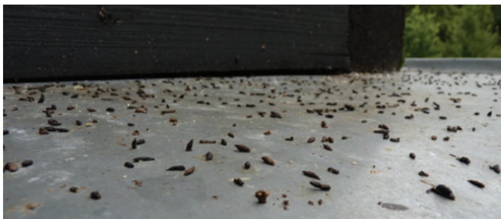
Fot. 74. Pod wejściem do kolonii liczącej setki osobników, na ziemi oraz na elewacji gromadzi się sporo odchodów (DZ).
