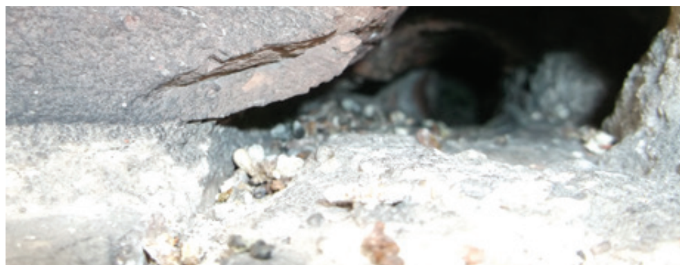
Fot. 84. Stare i wyblakłe odchody wskazują, że z tej kryjówki żaden nietoperz nie korzystał od dłuższego czasu (DZ).
