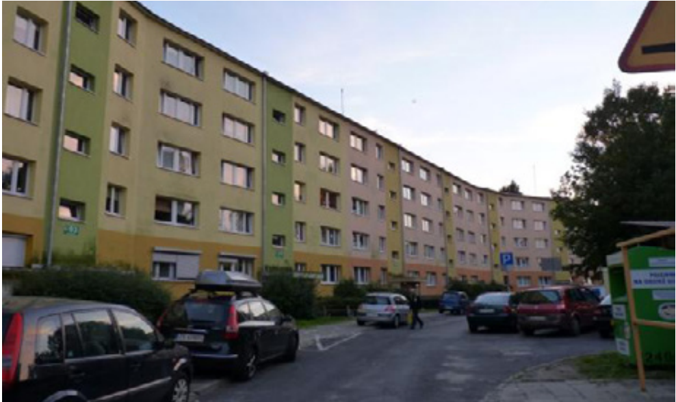
Fot. 1. W stropodachu tego bloku gniazdują setki par jerzyków.
