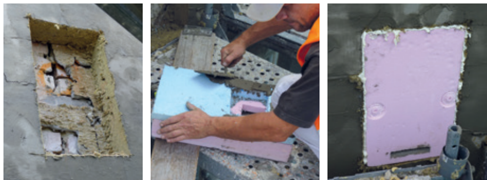
Fot. 105. Szczelina pomiędzy ceglami w ścianie tej kamienicy prowadziła do wykorzystywanego co roku zimowiska nietoperzy (DZ).
