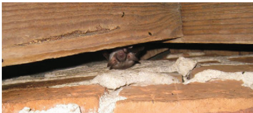
Fot. 94. Nocek kryjący się pomiędzy krokwią a ceglana ścianą (KK).
