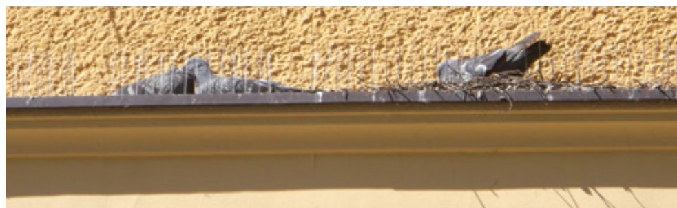
Fot. 128. Gołębie miejskie gniazdujące pomiędzy kolcami zamontowanymi na budynku Starostwa Powiatowego w Białogardzie, woj. Zachodniopomorskie (DZ).
