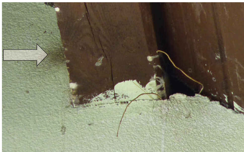
Fot. 34. Na tym zdjęciu widać dwie oznaki wskazujące, że ptaki mogą odbywać tu lęgi. Po prawej stronie wystaje materiał gniazdowy, po lewej widać pociemnienie pozostawione przez regularnie wchodzącego i wychodzącego w tym miejscu ptaka (DZ).
