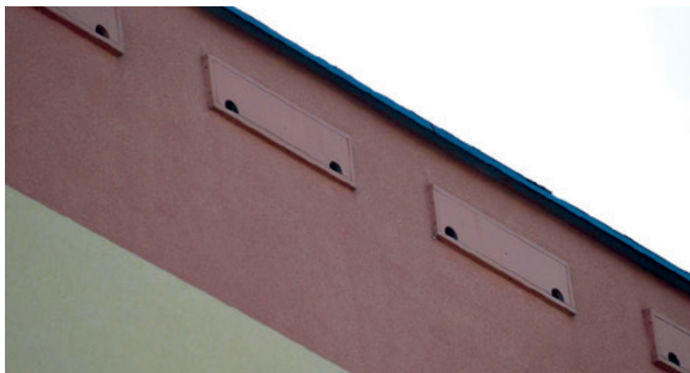
Fot. 107. Montowanie skrzynek podtynkowo, na wysokości stropodachu niweluje potencjalne oddziaływanie mostków termicznych na właściwości cieplne budynku (AT).
