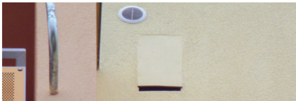
Fot. 112. Nie zawsze trzeba posiłkować się rozwiązaniami gotowymi. Ten schron dla nietoperzy powstał poprzez zamontowanie płyty z tworzywa sztucznego przykrywającej trzycentymetrową przestrzeń wyciętą w styropianie (DZ).
