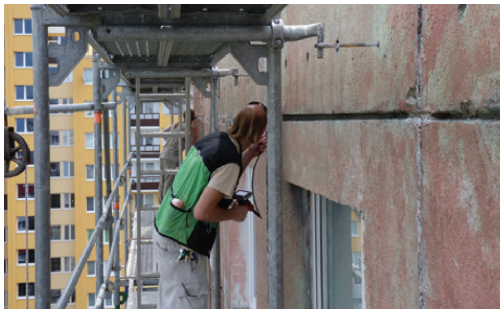
Fot. 99. Przeglądanie obiektu endoskopem z rusztowań. W razie odnalezienia lęgów ptaków lub kryjówek nietoperzy należy zmodyfikować harmonogram prac, co może oznaczać dodatkowe koszty dla wykonawcy (DZ).
