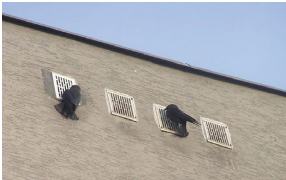
Fot. 11. Kawki próbujące się dostać do miejsc gniazdowania w stropodachu, który zakratowano. Pracując wytrwale potrafią wyrwać kratki po jakimś czasie (ML).
