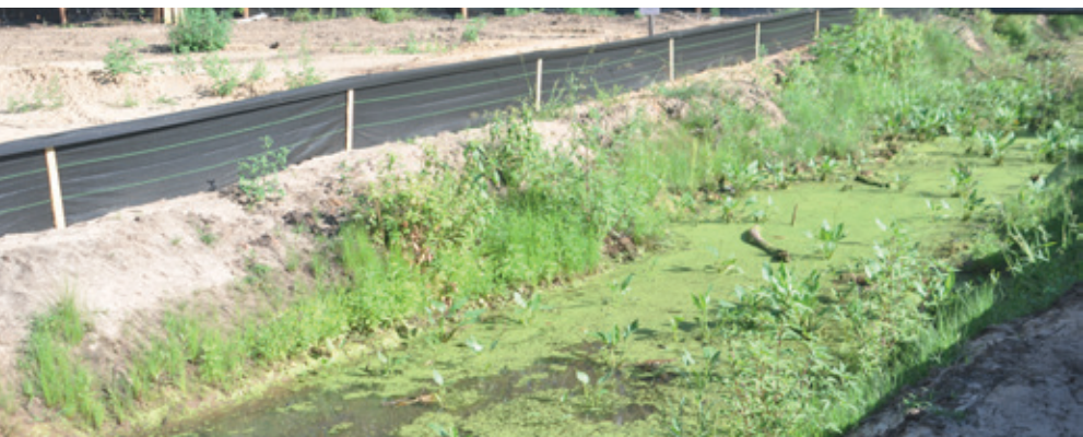
Płotek herpetologiczny na placu budowy wzdłuż rowu odwadniającego (fot. M. Wojciechowska)
