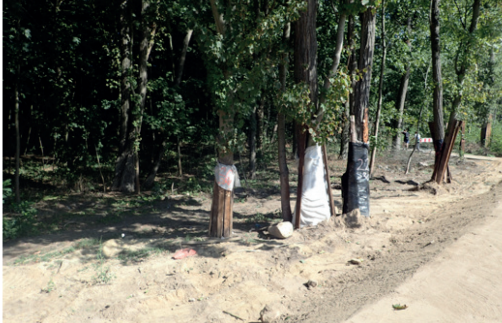
Podczas realizacji inwestycji chroni się drzewa, ale siedlisko to coś więcej... (fot. K. Ziarnek)
