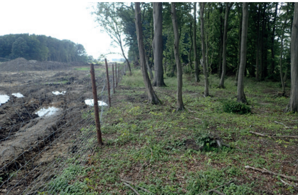
Ochrona siedlisk leśnych w trakcie realizacji inwestycji – grodzenie (fot. K. Ziarnek)
