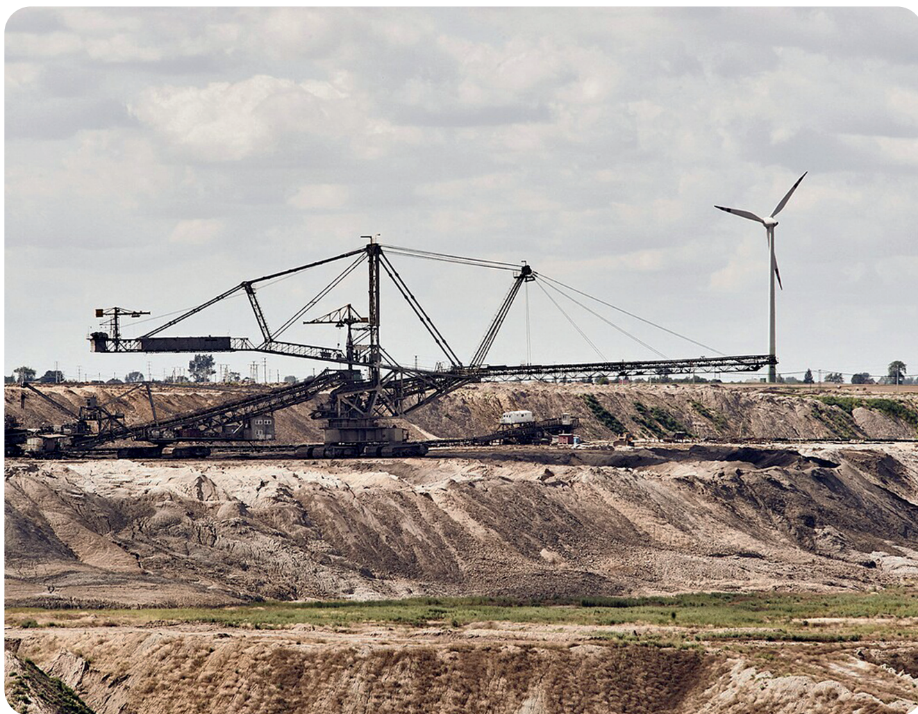
Widok na odkrywkę Kleczew, fot. Sławomir Jankowski
