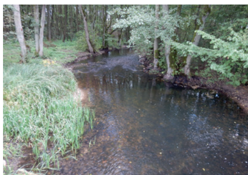
Ryc. 66. Bystrza urządzone poniżej progu i kanału obiegowego w Głęboczku uzupełniają efekt udroźnienia bariery.
