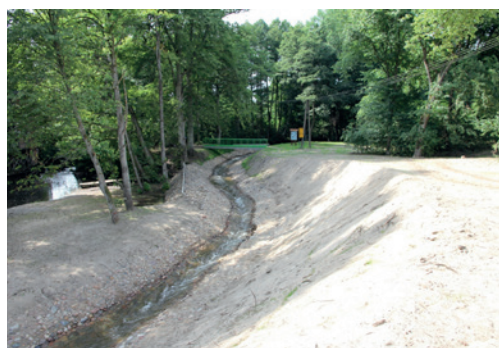
Ryc. 65. Naturopodobny kanał obiegowy na Drawie przy progu w Głęboczku. W projekcie kanału zastosowano reguły funkcjonowania układu bystrze/płoso Heya Thornea oraz wytyczne projektu Tarliska Górnej Raby Stowarzyszenia AB OVO. Projekt wykonało biuro projektowe DHV Hydroprojekt we współpracy z prof. Piotrem Dębowskim oraz Józefem Jeleńskim.
