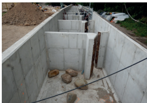
Ryc. 64. Nowa przepławka szczelinowa przy EW Kamienna na Drawie w Głusku. Zapora i jedna z najstarszych elektrowni wodnych na Świecie stały się gwoździem do trumny populacji łososia drawskiego. Nowa przepławka powinna dać szansę na powrót łososia na tarliska w środkowej Drawie po prawie stu latach.
